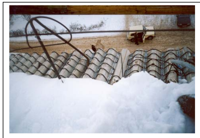
Рис. 3. Монтаж нагревательного кабеля Deviflex™ DTCE на лестнице и на крыше.
