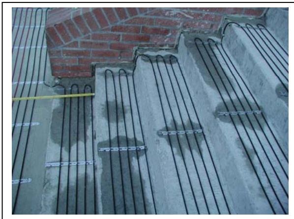
Рис. 3. Монтаж нагревательного кабеля Deviflex™ DTCE на лестнице и на крыше.
