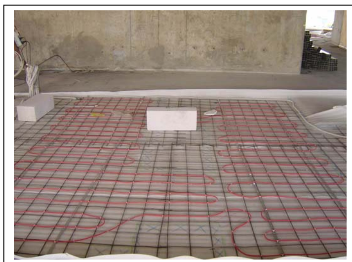
Рис. 4. Монтаж нагревательного кабеля deviflex™ DTIE-17 в жилом помещении.
