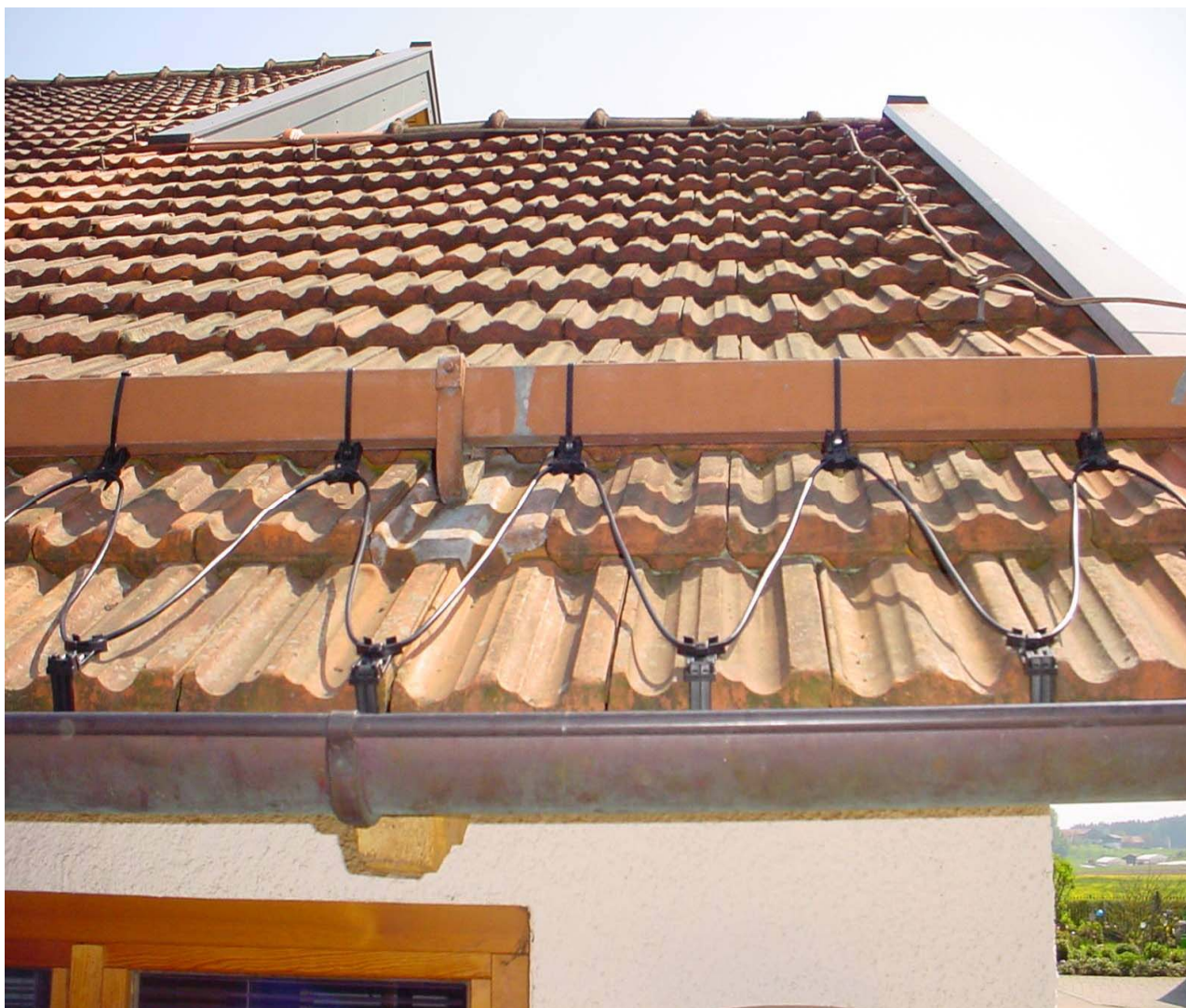
Рис.7.Использование пластиковых креплений Deviclip™Guardhook на кровле из натуральной черепицы.
